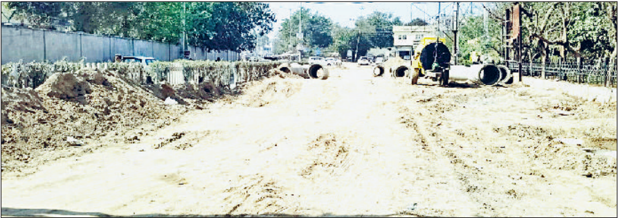
सिरसा। अंडरपास बनने से पहले सीवरेंज पाइप लाइन के लिए खोदी सड़क।
